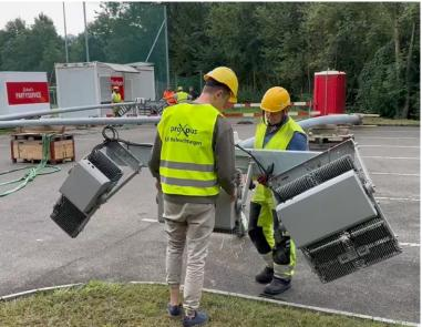
Die Montage der Strahler erfolgte am Boden. Danach wurden die vormontierten Masten per Helikopter auf die Fundamente gesetzt. Anschliessend erfolgte die Feinjustierung der Strahler und die Protokollmessung.
