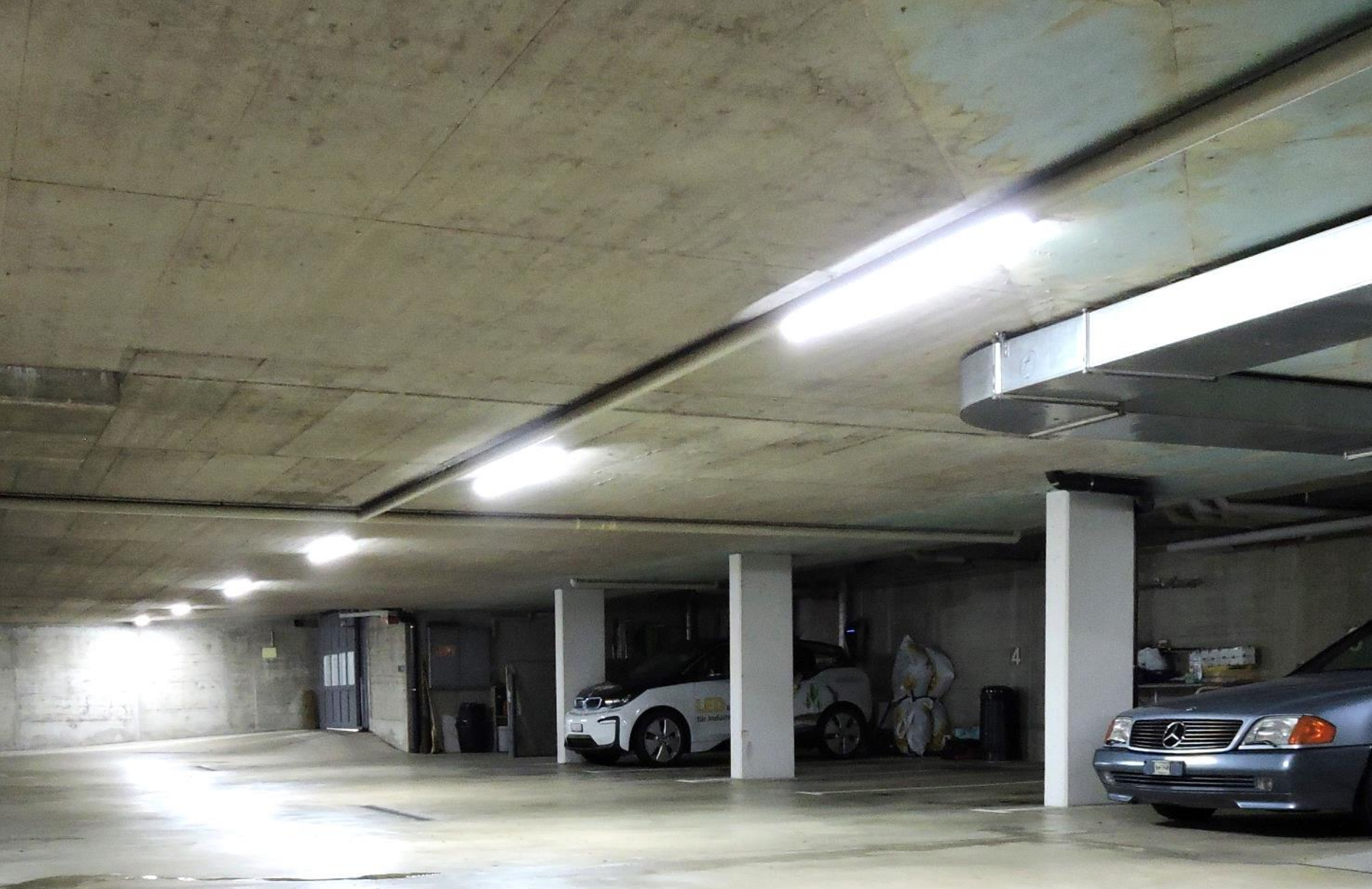
Überbauung Sälistrasse 11-15 in Däniken/SO
